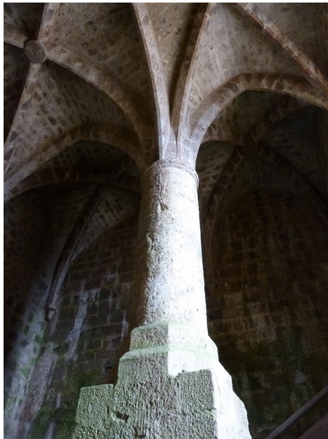
(fig.17) Voûte de la salle du pilier
