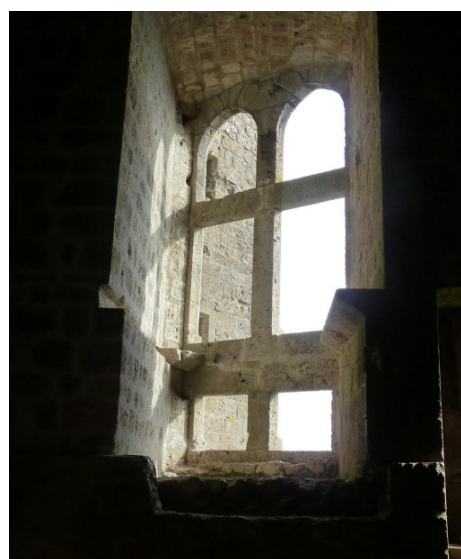
(fig.8) Baie de la salle du pilier
