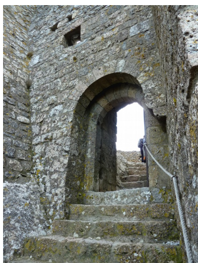
(fig. 5) Détail porte d'entrée basse avec assommoir
