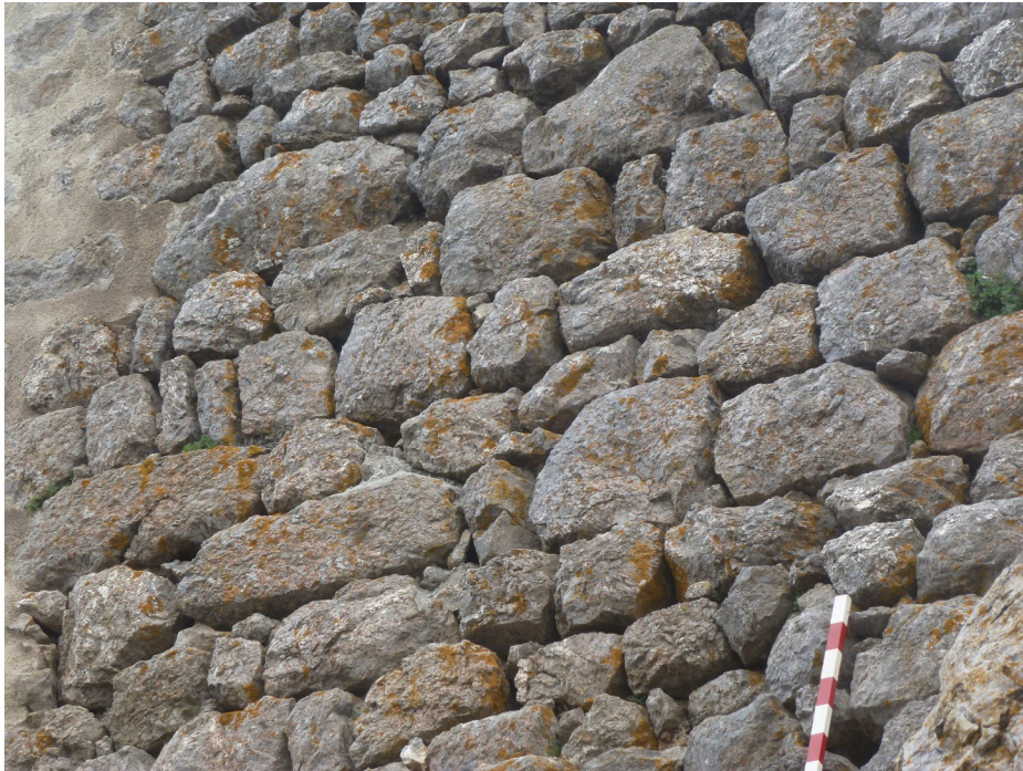
(fig.11) Mur extérieur ouest en grand appareil de la caserne
