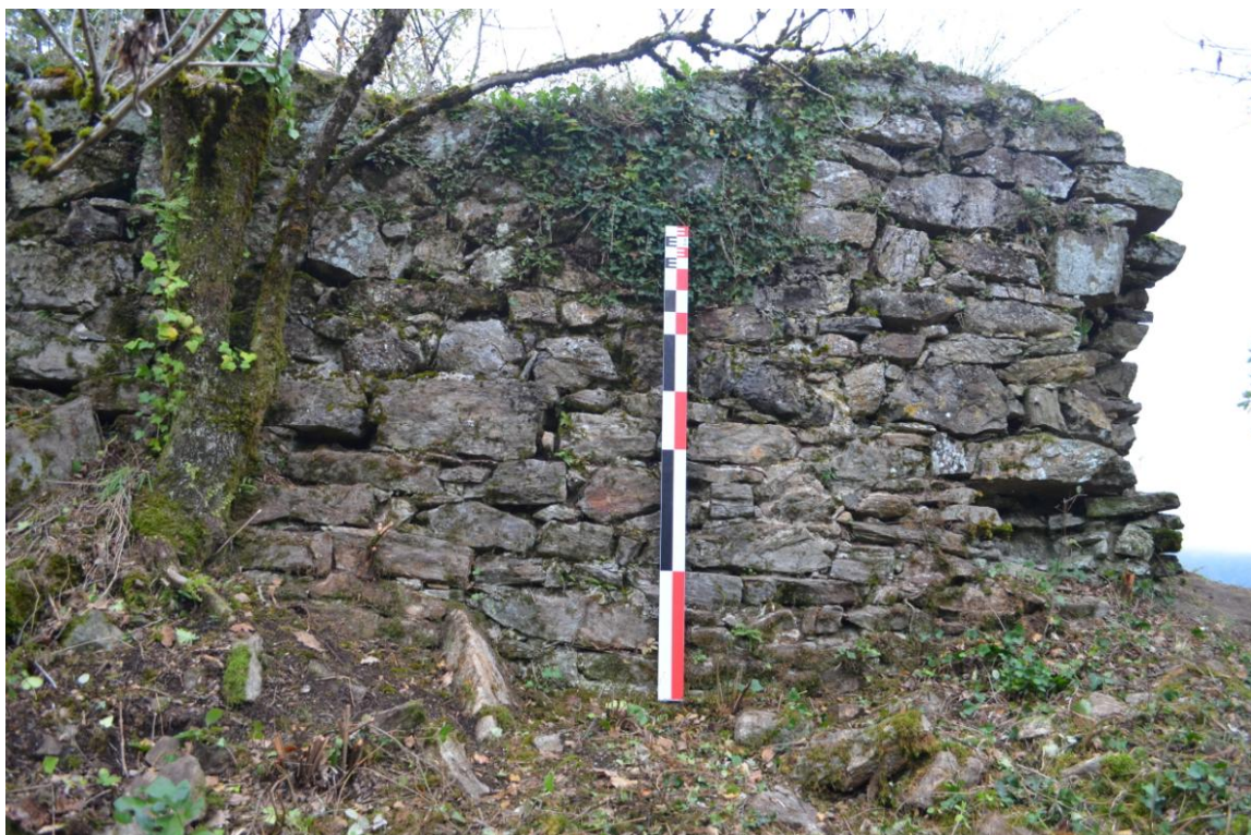
Fig. 9 : Partie sud du mur de 3 m d'épaisseur construit sur la roca de Saint-Sauveur
