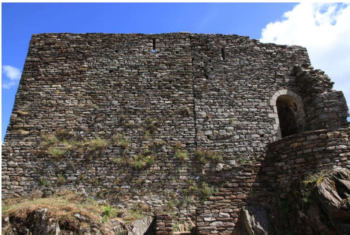
Elévation du mur ouest du château
