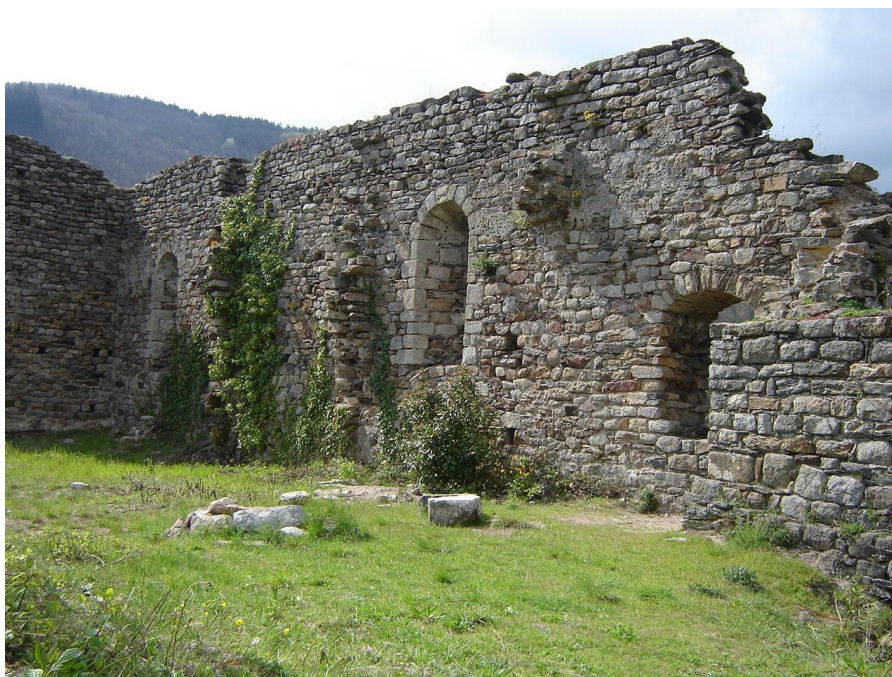
Fig. 6 : Le mur nord de l'église Saint-Sauveur
