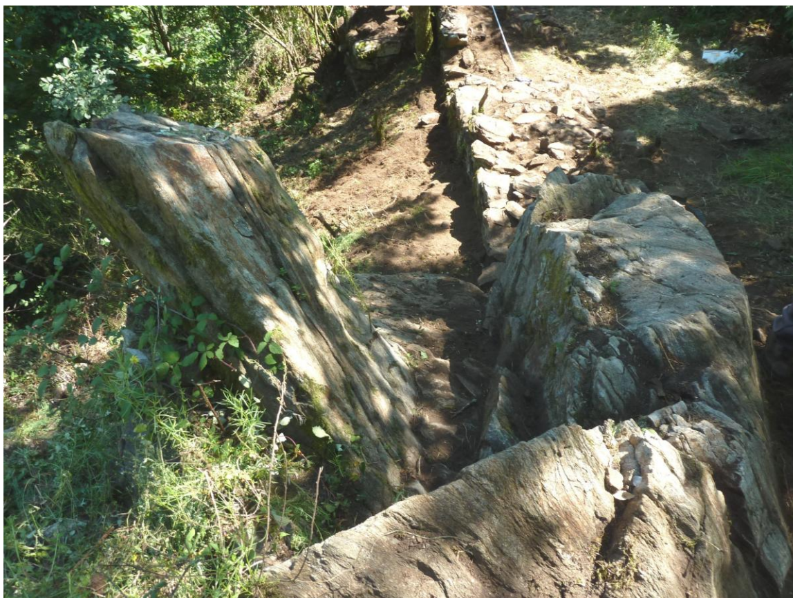
Fig. 10 : Zone de carrière à l'ouest de la roca de Saint-Sauveur. Au second plan, on aperçoit un des murs de la défense occidentale.
